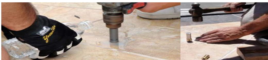
FURO DE CENTRO COM BROCA DE 5mm FURO FINAL COM BROCA DE 10mm
