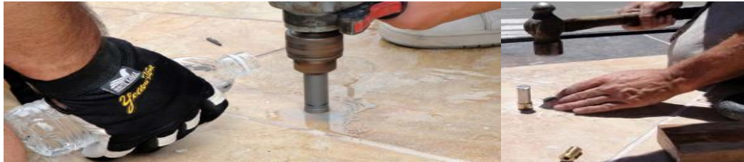
FURO DE CENTRO COM BROCA DE 5mm FURO FINAL COM BROCA DE 10mm
