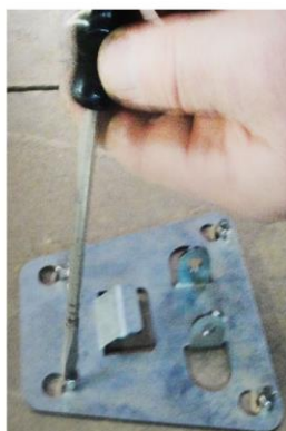
Fixar as bases metálicas utilizando 4 pinos-bucha conforme ilustração
